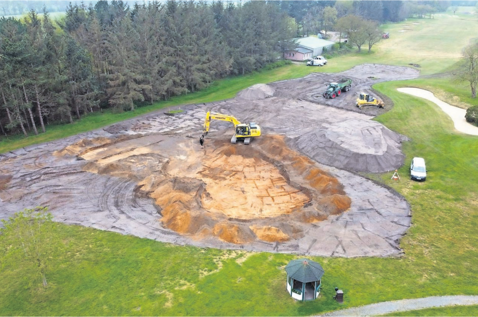
Für den Bau des neuen Chippodroms und den Umbau der Bahnen 11 und 12 wurde vergleichsweise wenig Erde bewegt, nämlich nur etwa 4000 Kubikmeter . Behutsam wurde das Neue in die bestehende Landschaft integriert. Fotos: Schöne
