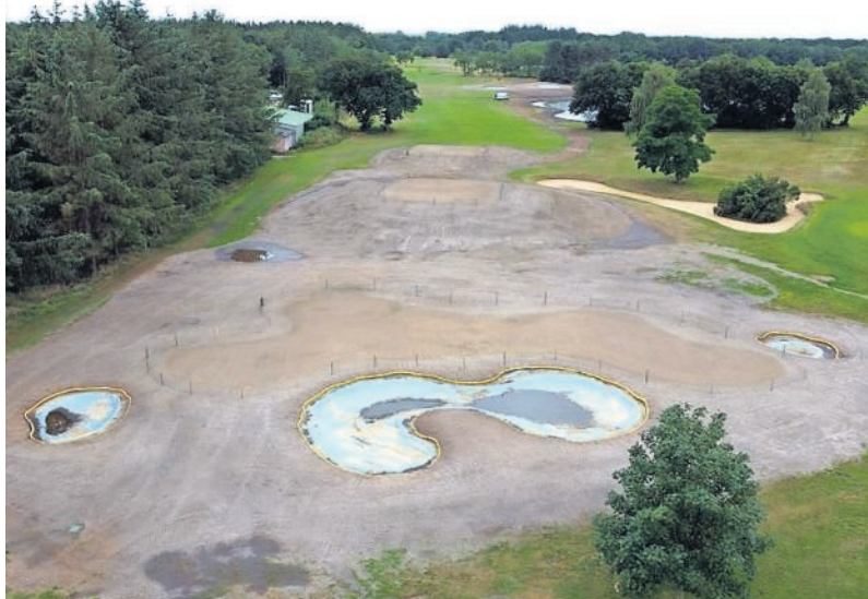
Nachdem das Chippodrom sein Profil und seine Sandhindernisse erhalten hat, wurde der Rasen eingesät .
